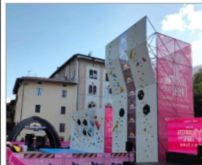
ESEMPIO PARETE ARRAMPICATA AUTOPORTANTE
